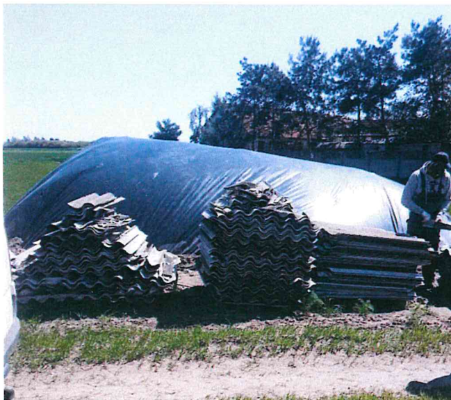
Rozebrane elementy dachów z materiałów zawierających azbest.
