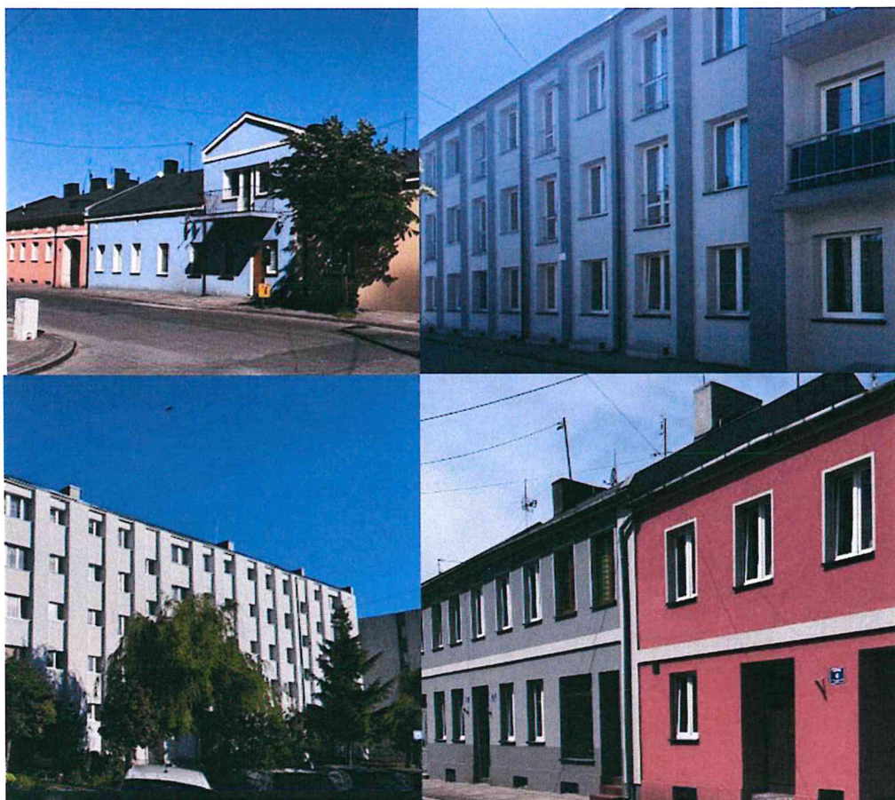
Przykładowe budynki mieszkalne w zasobie komunalnym ZGM po termomodernizacji. Kolejno od góry-lewo: ul. 1 Maja 20, 22 i 24, ul. Młyńska, ul. Dąbrowskiego, ul. 1 Maja 4, 6 i 8.
