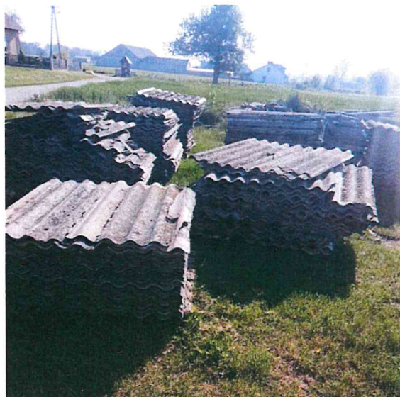
Rozebrane elementy dachów z materiałów zawierających azbest.
